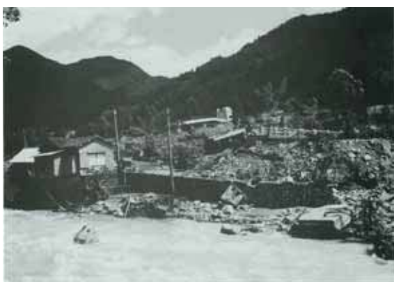
揖保川が土砂で埋没し流路が変わった状況 （宍粟市一宮町 にしごか 西深）
