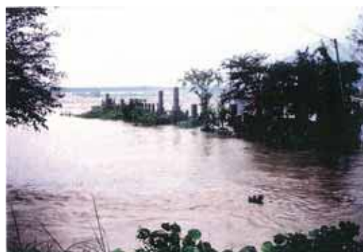
河東大橋南側浸水状況 かわひがし
