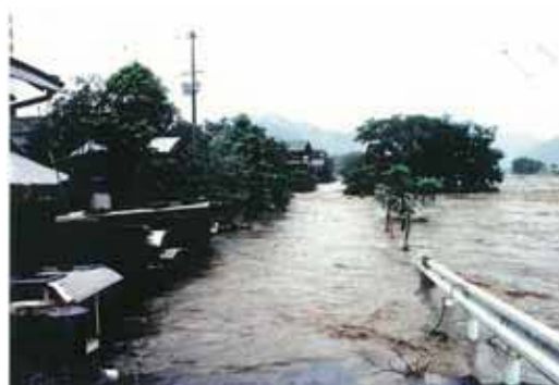
穴栗橋右岸浸水状況
