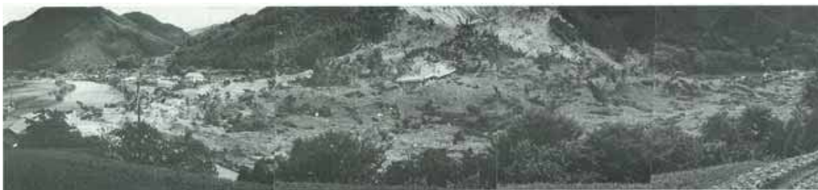
左岸山崩により揖保川を堰き止めた（宍粟市一宮町 ふくち 福知付近）
