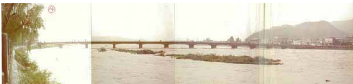
洪水中の龍野橋の状況
