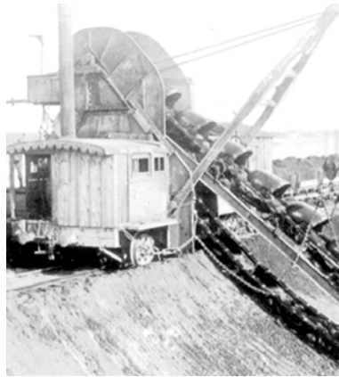
大正期の新水路掘削作業 ※写真出典：北海道開発局
