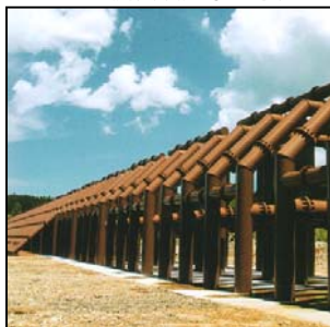
富良野川3号透過型ダム
