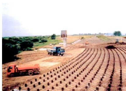
パイルネット工法
