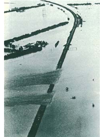
下新篠津築堤の破堤状況
