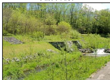
オカバルシ川床固工群
