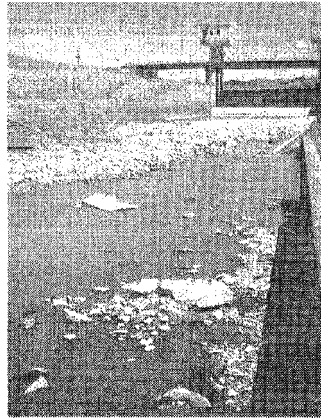
水不足で、頭首口下流で川底が姿を現した三笠市内の幾春別川＝23日
