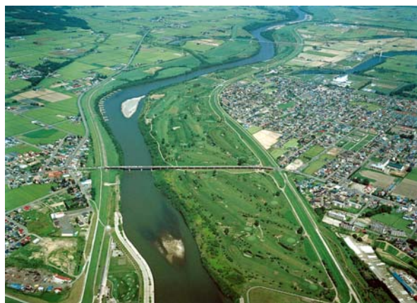
石狩川橋(KP94.00)付近
