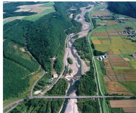
志比内橋 (KP25.80) 付近
