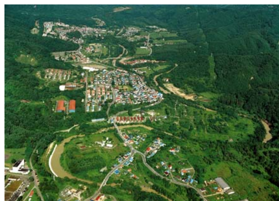
奔幌内橋 (KP29.60) 付近
