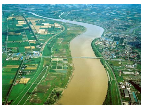
石狩大橋 (KP26.60) 付近
