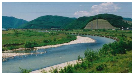
新空知橋(KP68.00)付近
