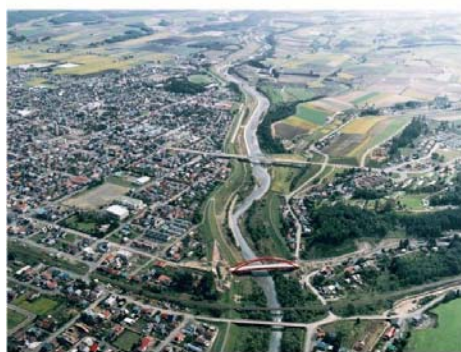
美瑛川橋梁(JR)(KP31.60)付近
