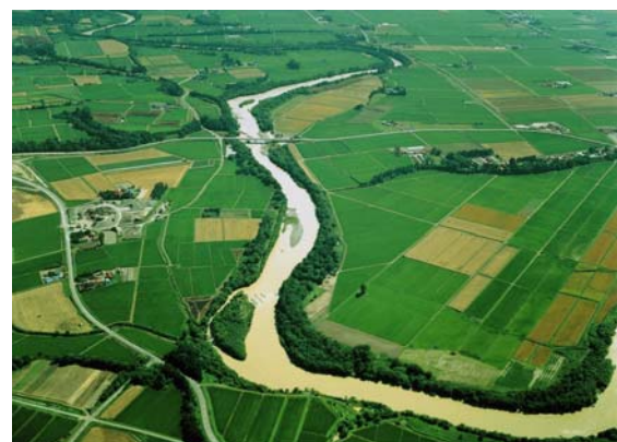
多良津橋 (KP34.00) 付近
