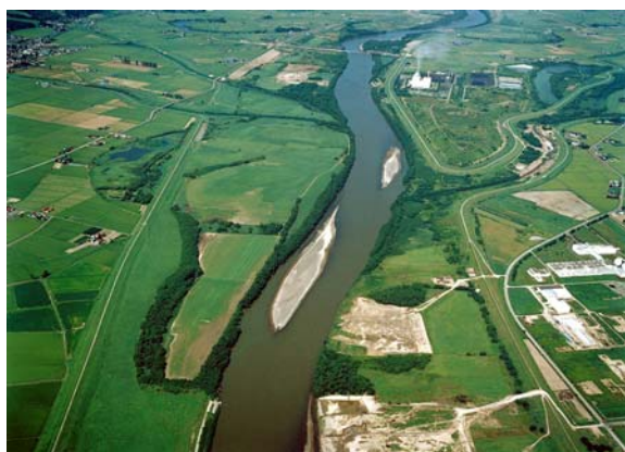
奈井江大橋 (KP76.80) 付近
