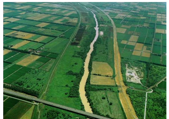
夕張川橋 (KP3.25) 付近
