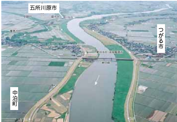
【14.0k 岩木川・旧十川合流点付近の河道の状況】
