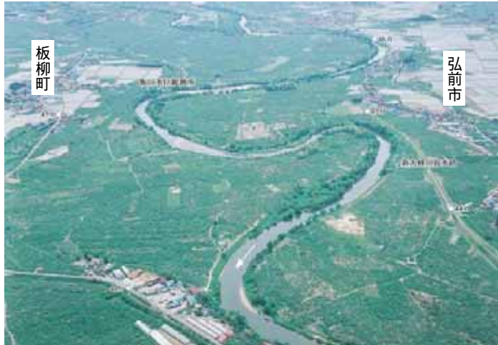
【44.0k 付近の河道の状況】
