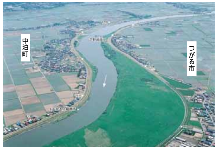
【9.0k 付近の河道の状況】
