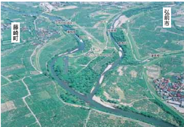
【46.0k 岩木川・平川合流点付近の河道の状況】
