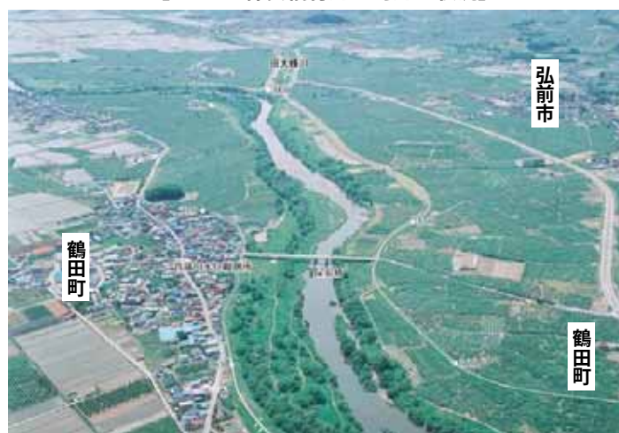
【36.0k 保安橋付近の河道の状況】
