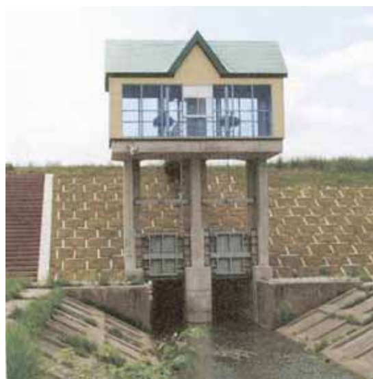
平川第五排水樋管
