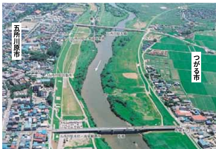
【27.0k 乾橋付近の河道の状況】
