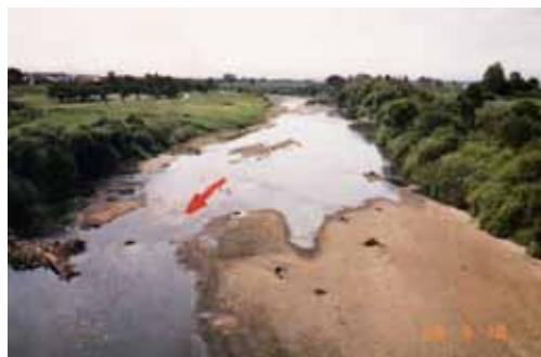
幡龍橋上流地点 (岩木川 43.0km 付近)
