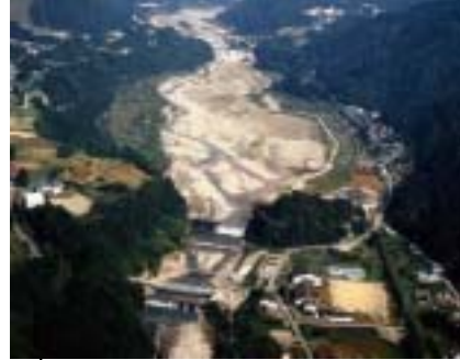
本宮砂防堰堤
