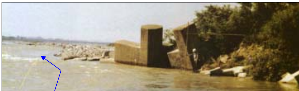
(上写真) 河床の局所洗掘により巨大水制が傾く（立山町利他地先）
