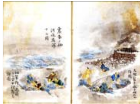
(左上写真) 安政五年常願川非常洪水山里変地之模様見取図「里方図」 水害の様子を描いている
