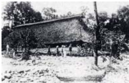
(写真) 旧上新川郡島村朝日地先 荒廢河川特有の土砂を含んだ氾濫流により、家屋が埋没した。
