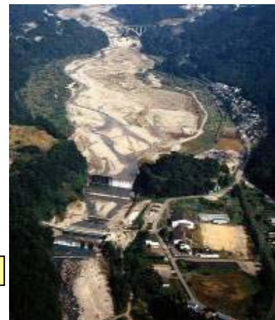
本宮砂防堰堤
