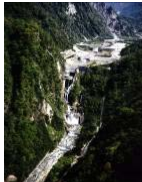
白岩砂防堰堤
