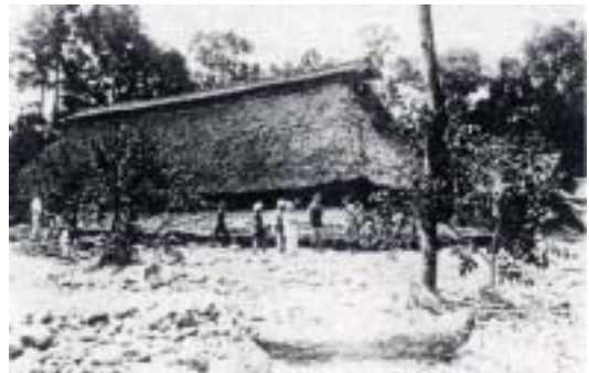
（写真）旧上新川郡島村朝日地先 荒廃河川特有の土砂を含んだ氾濫流により、家屋が埋没した。
