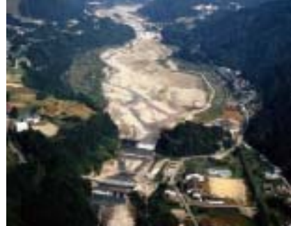
本宮砂防堰堤
