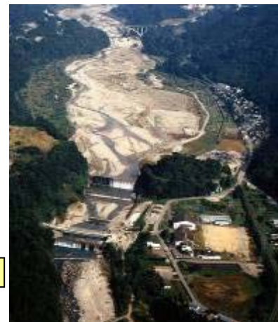
本宮砂防堰堤
