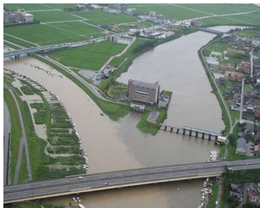
図 9-3 前川排水機場
