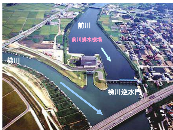
図 4-18 前川排水機場
