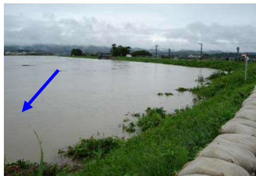
図 4-6 梯川 白江大橋上流左岸の状況 （平成 18 年（2006 年）7 月 17 日撮影）
