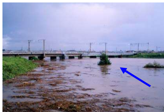
図 4-4 梯川 JR（当時）梯川鉄橋付近の状況 （平成10年（1998年）9月22日撮影）
