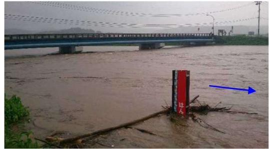
図 4-7 写真 梯川 鴨浦橋下流の状況 (平成 25 年（2013 年）7 月 29 日撮影)
