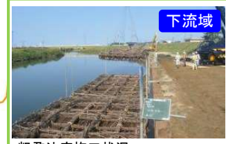
粗朶沈床施工状況(水際環境の創出)
