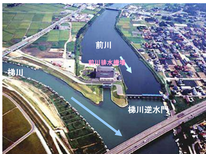
前川排水機場
