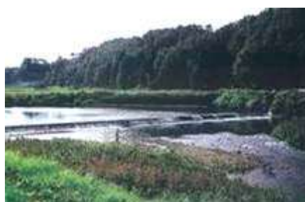
軽海用水頭首工
