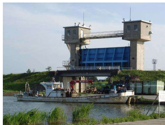
安宅漁港水門
