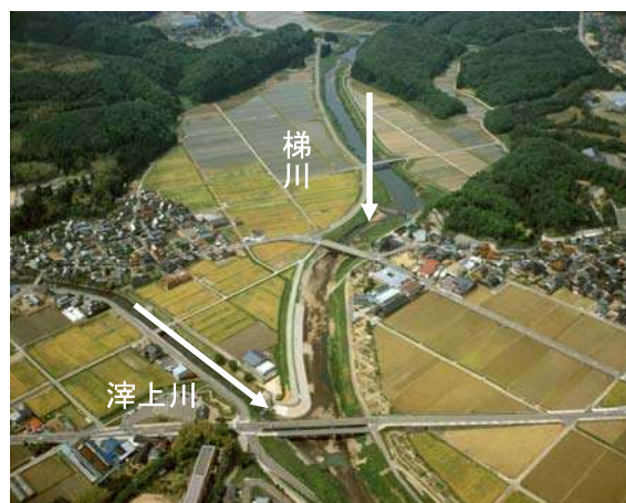
滓上川合流部(河口より 10.7km) 付近
