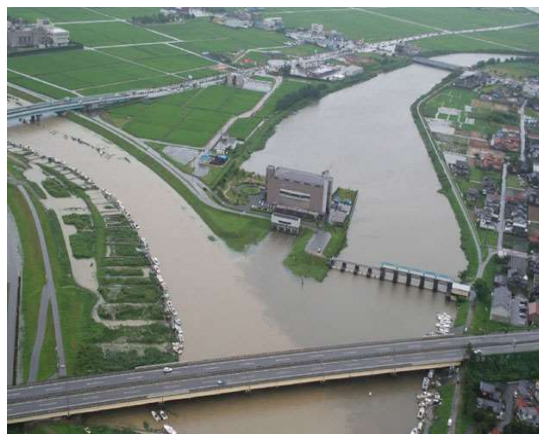
前川排水機場
