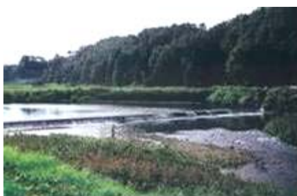
軽海用水頭首工
