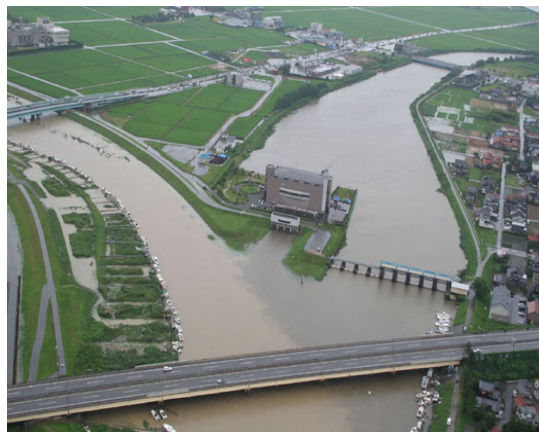
前川排水機場
