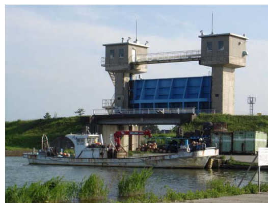
安宅漁港水門
