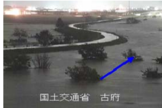
梯川 古府付近の状況 (平成 16 年 10 月 20 日撮影)
