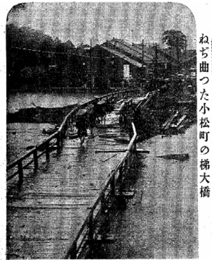
流出直前の梯大橋
