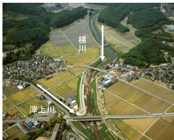
滓上川合流部(河口より10.7km)付近
