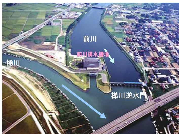
前川排水機場
