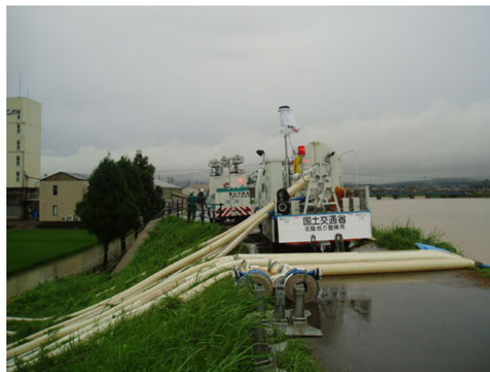
川田川樋管排水ポンプ車
