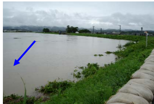
梯川 白江大橋上流左岸の状況 (平成 18 年 7 月 17 日撮影)
