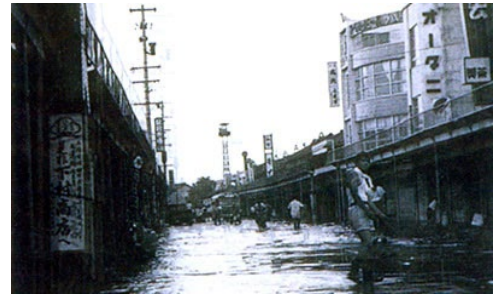
西脇市内の浸水状況
