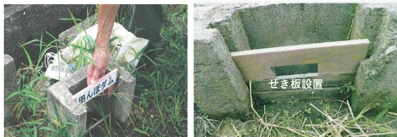
図－4.3.2 田んぼダムの整備事例（加東市）
