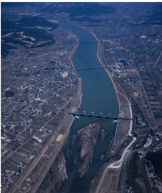
▲ 加古川大堰湛水区間
