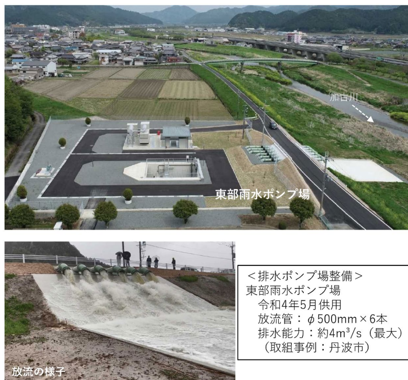
図－4.3.5 排水ポンプ場の整備事例（丹波市）
