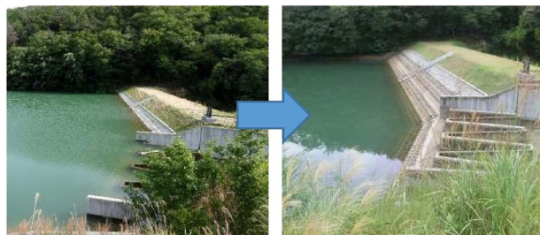
図－4.3.1 ため池の水位調整事例（加東市）
