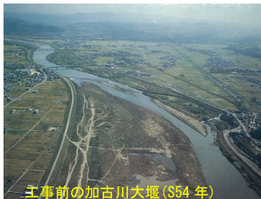
工事前の加古川大堰 (S54 年)
