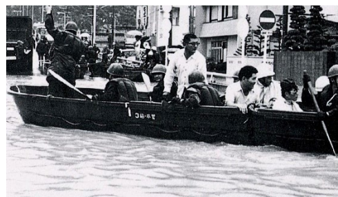
高砂市街地の浸水状況
