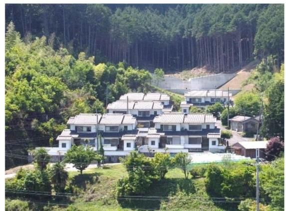
多可町加美区の場（丁田谷川）の不透過型堰堤＋鋼製流木止工
