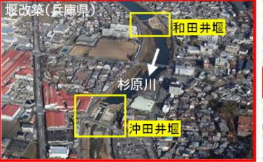
＜堰改築・橋梁改築＞姫路河川国道事務所・兵庫県
