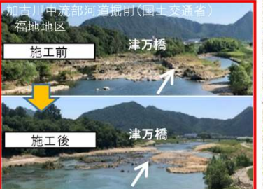
＜河道改修・堤防整備・護岸整備＞姫路河川国道事務所
