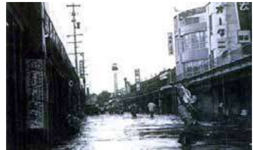
西脇市内の浸水状況
