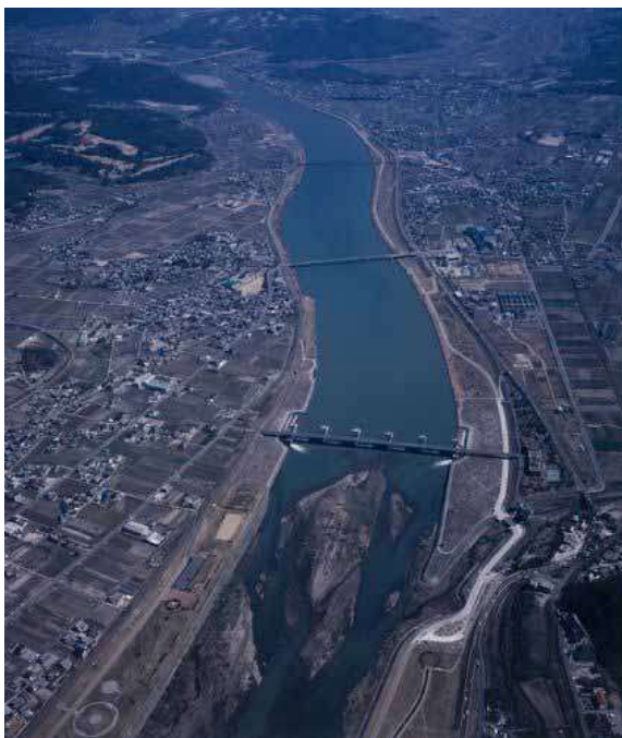
▲ 加古川大堰湛水区間
