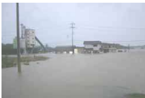
右岸 32.6k の浸水状況
