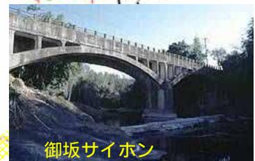
「御坂サイホン」はわが国初の「サイホン（噴水管）工法」による鉄管が通っている。これは加古台地への引水のため淡河川から導水し、志染川を逆サイホンで渡す淡河川疏水工事によってつくられた。
