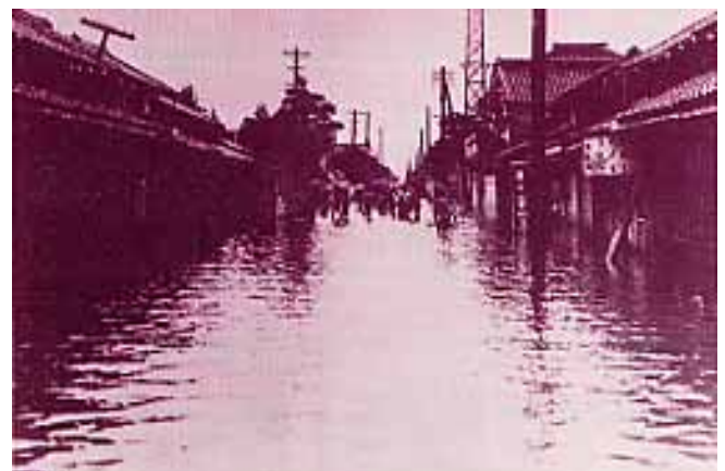
堀之内の浸水状況
