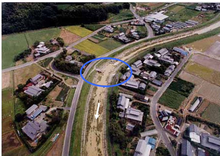
第一城東橋（下小笠川3.8 km）の落橋
