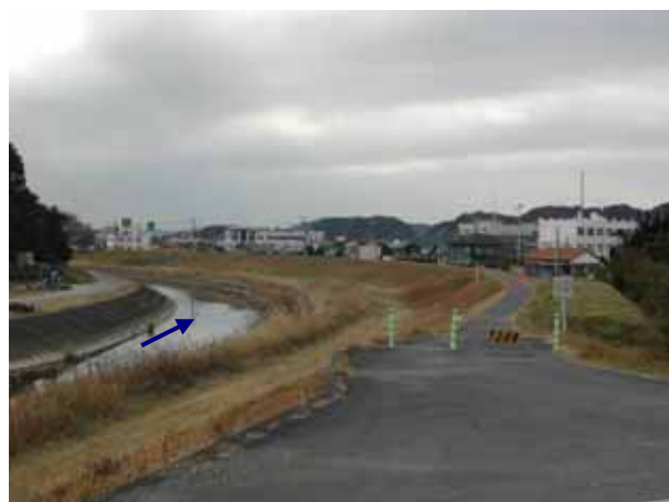
図-7.3 堤防状況(右岸 12.5 km付近)
