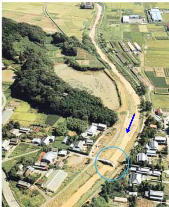
赤土橋の落橋 (丹野川 1.8km 付近)
