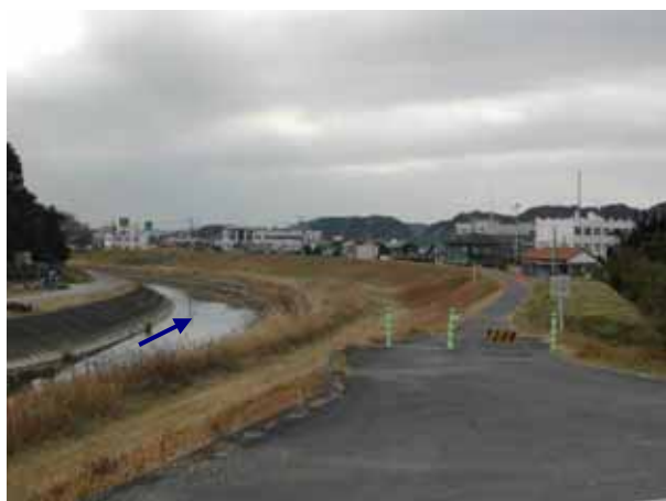
図-7.3 堤防状況(右岸 12.5 km付近)
