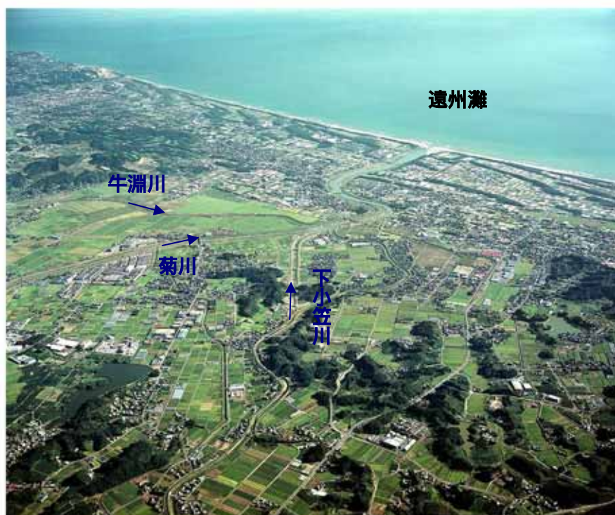
図-3.1 流域内の土地利用状況
