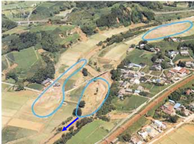
破堤による氾濫 (菊川 16.0km、17.2km、17.6km 地点)
