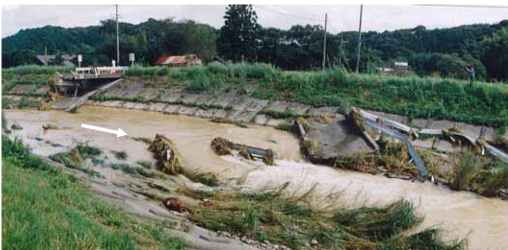
落橋後の状況
