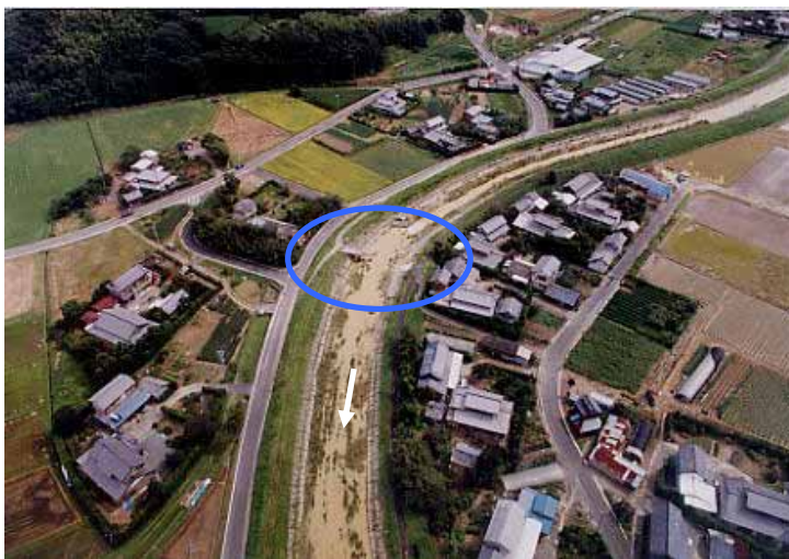
だいいちきとうぼし しもおがさかわ 第一城東橋（下小笠川3.8 km）の落橋
