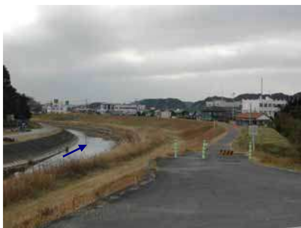
図-7.3 堤防状況（右岸 12.5 km付近）
