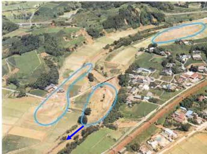
破堤による氾濫 (菊川 16.0km、17.2km、17.6km 地点)
