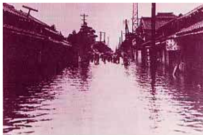
堀之内の浸水状況
