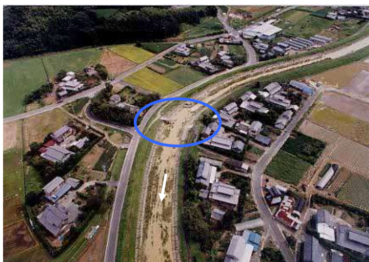
第一城東橋（下小笠川3.8 km）の落橋
