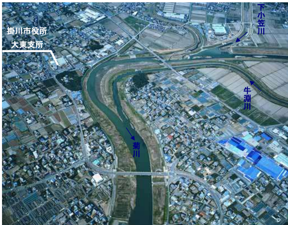
図-3.3 下流域の沿川（市街化状況）＜掛川市＞
