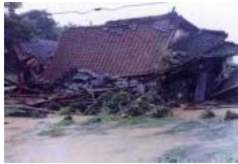
写真 4-4(2) 支川合志川 4.6km 付近(植木町)洪水により倒壊した家屋
