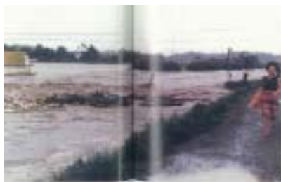
写真 4-4(6)米塚橋の流失直後
