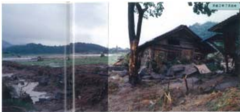
写真 4-6(2)本川 16km 付近(玉名市)月田地区の民家被災状況
