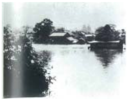
写真 4-2(3) 本川 34km 付近 (山鹿市) 左岸、南島地区の状況
