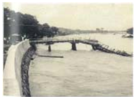
写真 4-2(4) 本川 33km 付近 (山鹿市) 右岸、山鹿橋の流失
