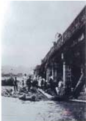
写真 4-2(2) 本川 17km 付近 (菊水町) 内藤橋にかかった流木
