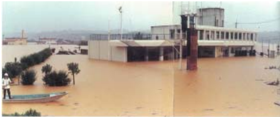
写真 4-4(4)支川吉田川 0.8km 付近(山鹿市)消防署付近の浸水状況
