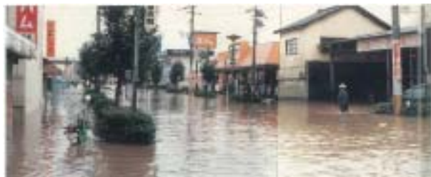
写真 4-5(6)たかもり荘付近の特殊堤より越水状況(山鹿市泉町)
