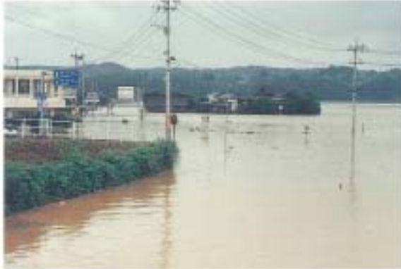
写真 4-6(3)国道 443 号の出水状況(山鹿市)
