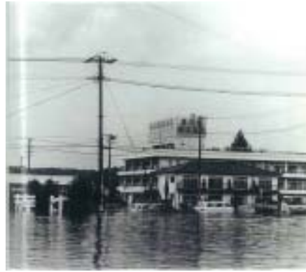
写真 4-5(3)山鹿市新町付近の浸水状況
