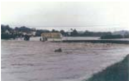
写真 4-4(5)支川合志川 4km 付近(植木市)米塚橋流失直前の状況
