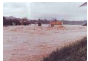
写真 4-4(7)米塚橋の流失直後
