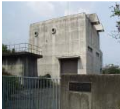
【玉名排水機場】
