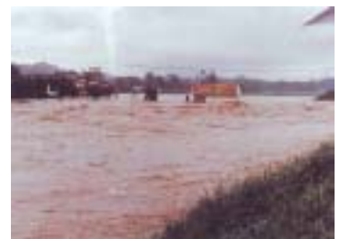
写真 4-4(7)米塚橋の流失直後Ⅱ
