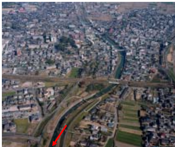
【7.375k 玉名市永徳寺の鉄道橋付近における河道の状況（支川繁根木川）】
