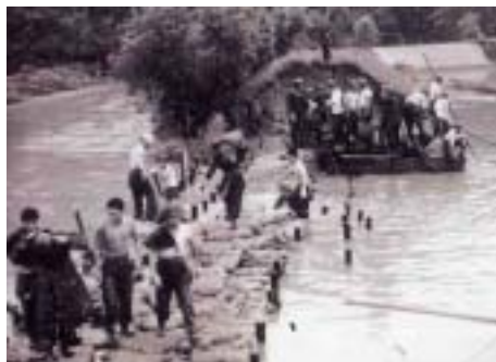
写真 4-3(2)支川江田川 1km 付近 (菊水町) 江田川堤防の決壊
