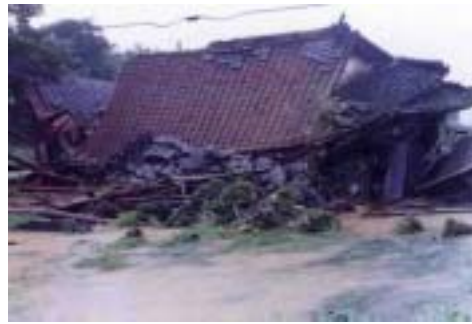
写真 4-4(2) 支川合志川 4.6km 付近(植木 町)洪水により倒壊した家屋
