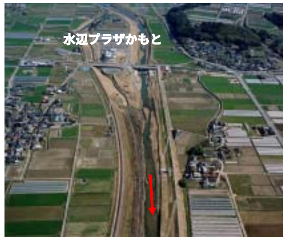
【2.0k 山鹿市水辺プラザかもと付近の河道の状況（支川上内田川）】
