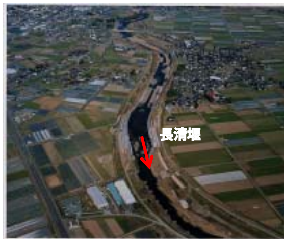
【48.5k 菊池市深川の長清堰付近における河道の状況】
