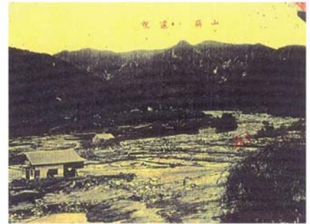
高山町大字後田字方野地先被害状況
