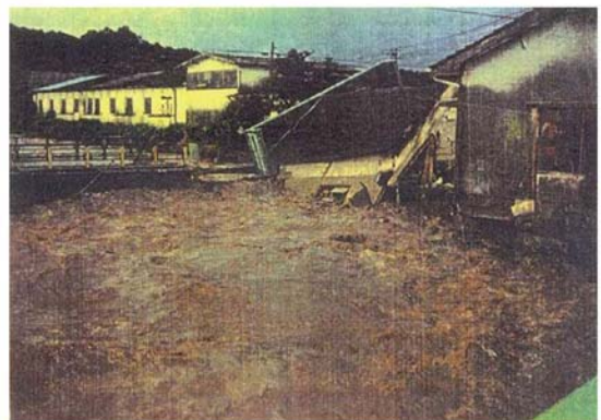
下谷川（田崎橋下流左岸）被害状況
