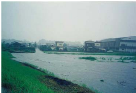
高山川左岸 2/000 付近（高山町内） 被害状況
