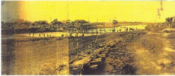
高山川 2/300 付近（高山橋）被害状況
