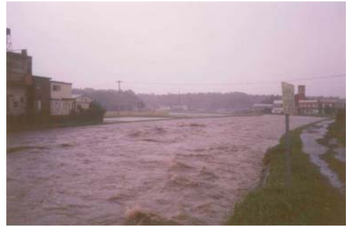
肝属川 20/000 付近（王子橋下流） 被害状況
