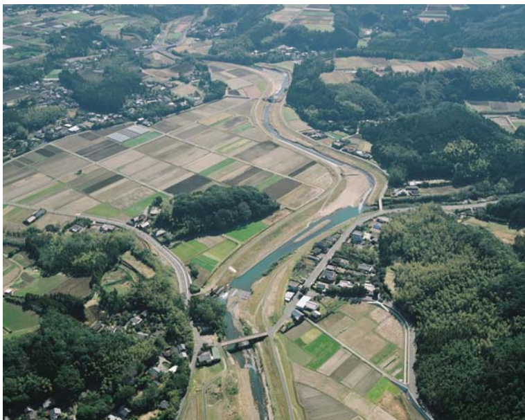
写真 8 - 9 始良川（鶴峯床止付近：6km 付近）
