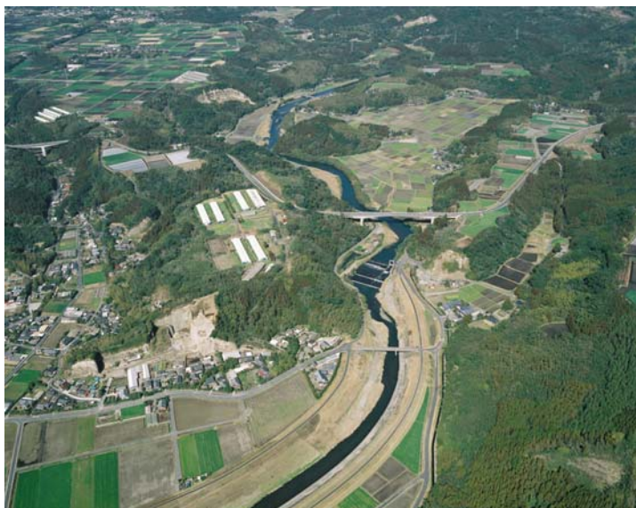
写真8-7 串良川（林田堰付近：9 km 付近）
