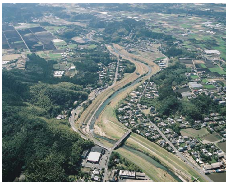
写真8-8 高山川（高山橋付近：3.4k 付近）
