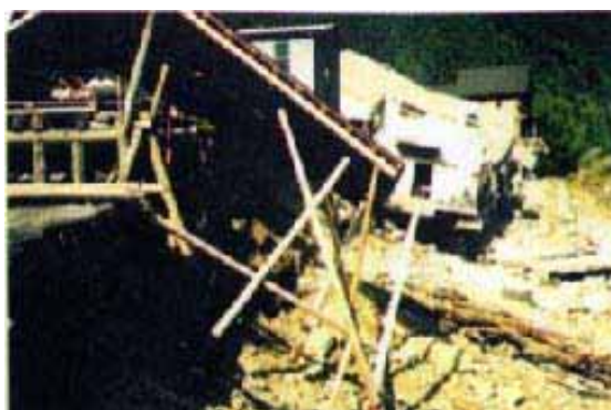
倒壊した木工センター ( かわがみ うのかわ 川上村東川付近)
