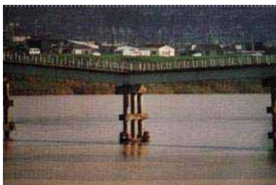
南海橋の陥没被害
