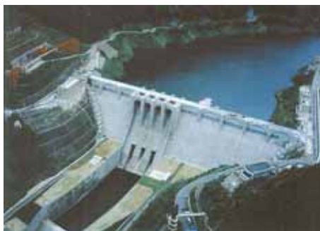
大滝ダム本体
