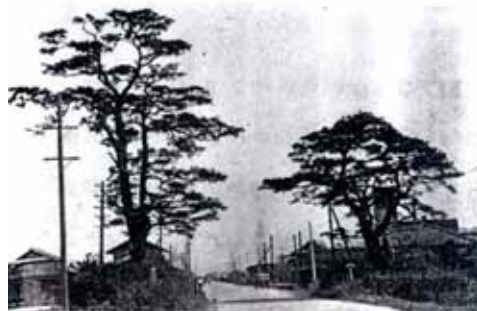
松原堤：和歌山市四箇郷付近
