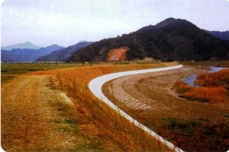
遠敷川左岸築堤・護岸工事後
