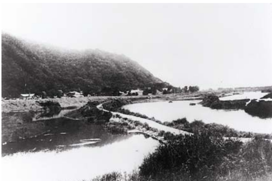
改修工事前の亀の甲付近
