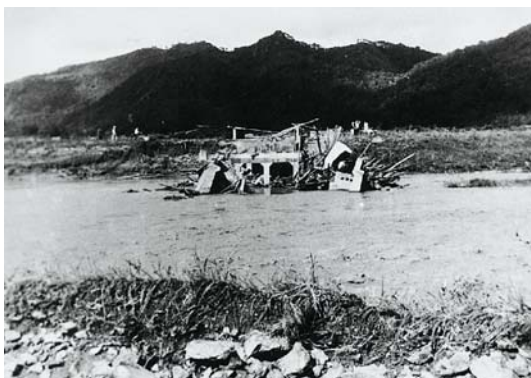
流出した丸山橋
