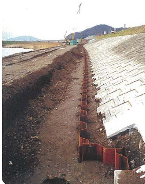
漏水対策工事実施状況
