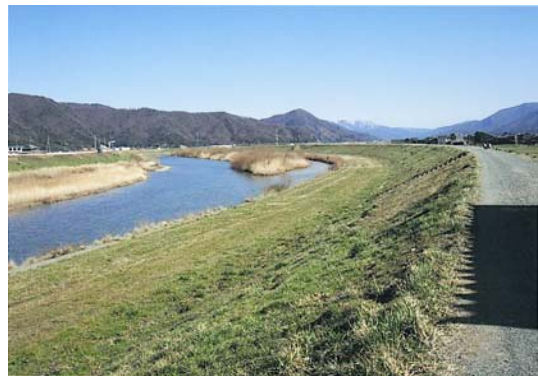
平成15年の左岸2.0kmより上流を望む
