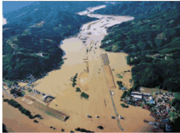
平成14年7月洪水時の浸水状況
