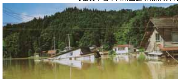
写真 平成 14 年の被害状況（砂鉄川）
