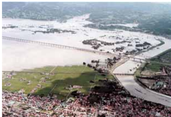
写真 昭和 56 年の被害状況（一関市）
