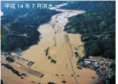
砂鉄川と北上川の合流点付近の浸水状況
