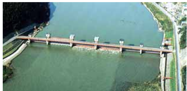
写真上：飯野川可動堰（昭和7年竣工）
