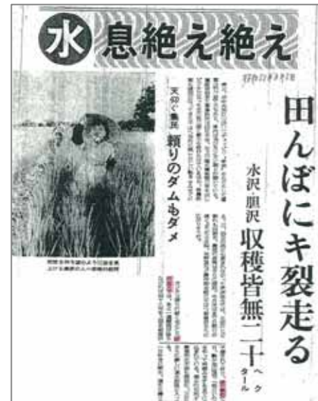
石淵ダム・湯田ダムでは貯水率が0%を切り、発電事業者の協力を得て、最低水位以下の緊急放流を実施
