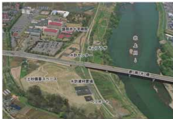
写真：つしだ 津志田地区河川防災ステーション
