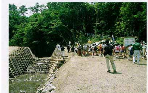
砂防えん堤探検隊
