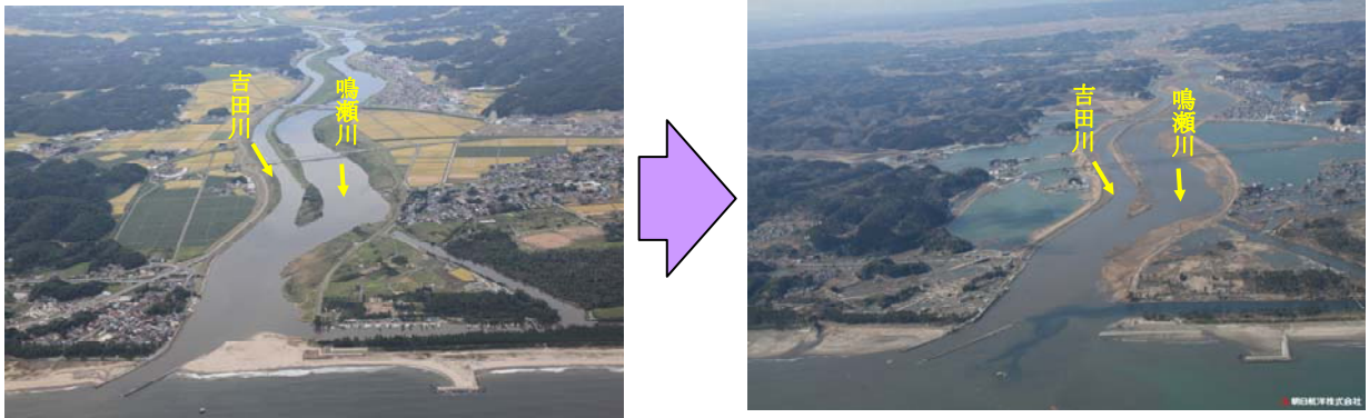
図 1-12 被災前後の比較（鳴瀬川河口部）
