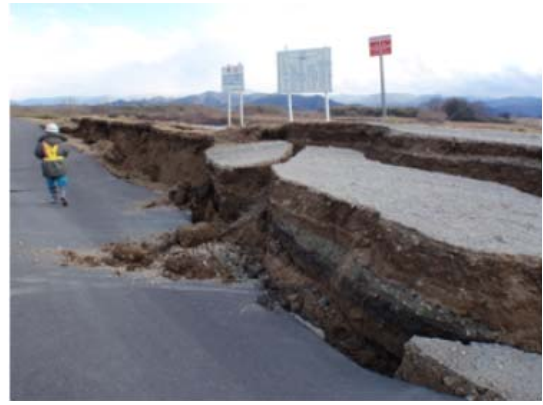
阿武隈川右岸 31.0k 付近 (角田市枝野地先) ※地震による堤防沈下
