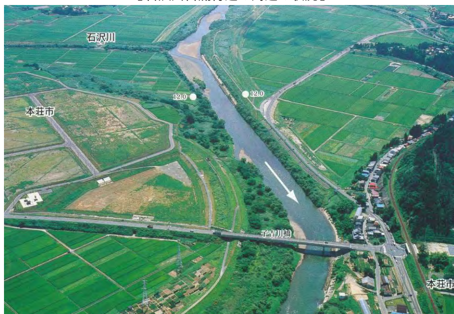
【石沢川合流付近の河道の状況】
