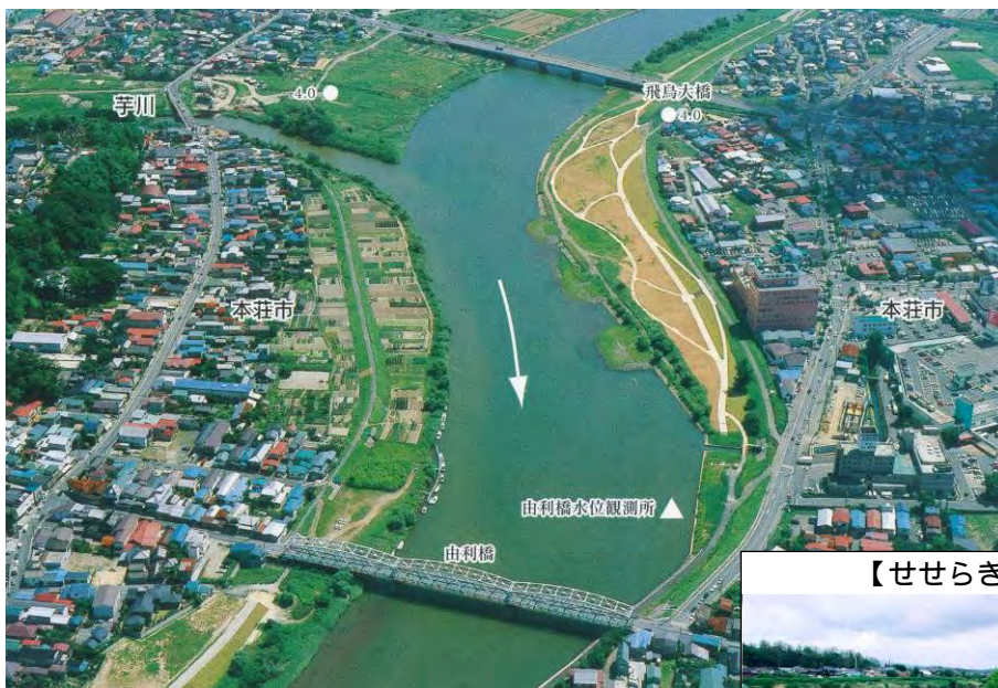
【芋川合流付近の河道の状況】
