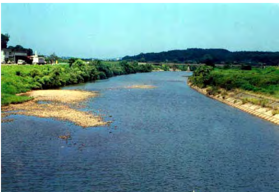
由利町滝沢橋下流(子吉川 16km 付近)
