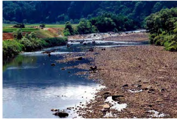
由利町長瀬橋上流(子吉川 20.5km 付近)
