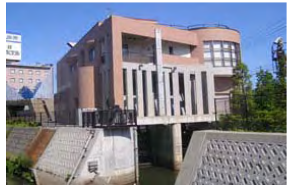
【大沢川排水機場】
