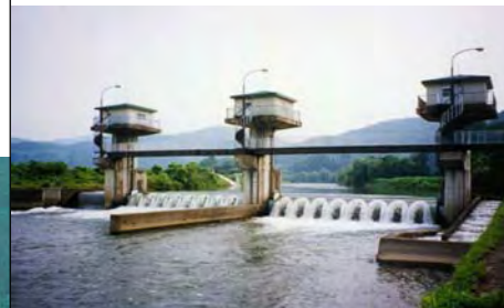
【河口から 24.5k にある滝沢頭首工】
