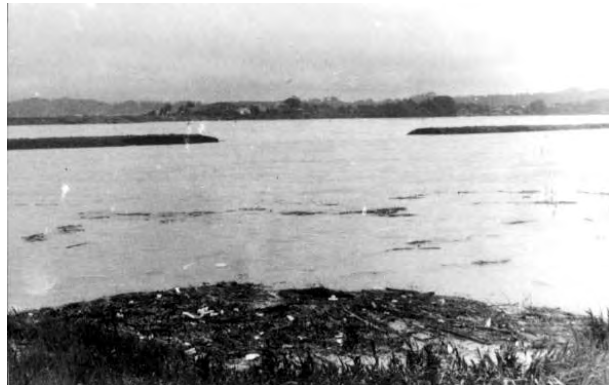
堤防破堤箇所(宮内)を右岸より望む 出典:秋田河川国道事務所資料
