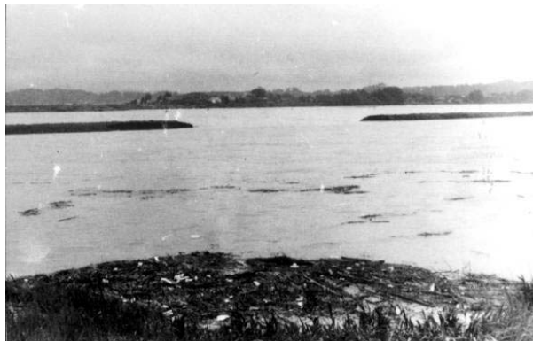
堤防破堤箇所(宮内)を右岸より望む
