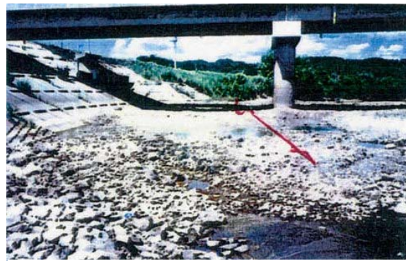
本荘市石沢地区烏川端下流(石沢川 2.4km 付近)
