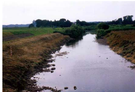
本荘市鮎瀬橋下流(石沢川 1.2km 付近)
