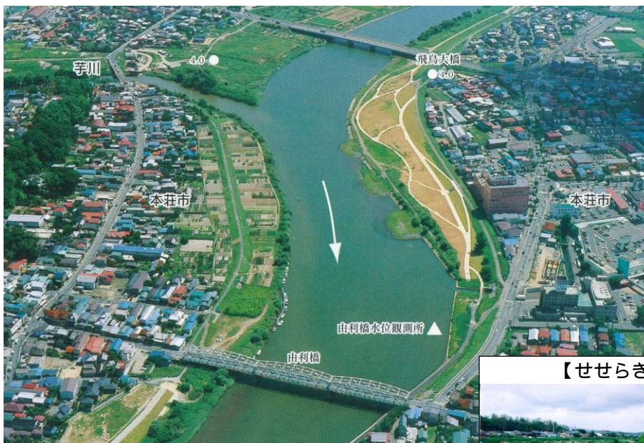
【芋川合流付近の河道の状況】
