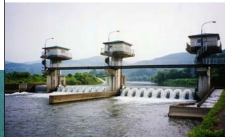
【河口から 24.5k にある滝沢頭首工】
