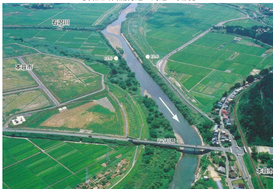
【石沢川合流付近の河道の状況】
