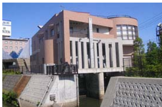
【大沢川排水機場】
