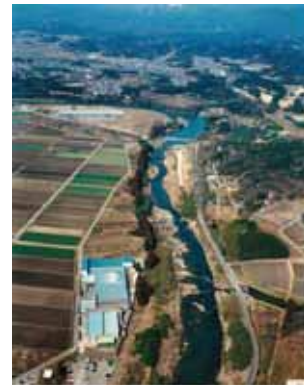
雲出川本川中流 （20km 付近）
