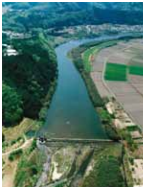
雲出川本川中流 （16km 付近）
