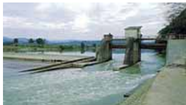
雲出井頭首工
