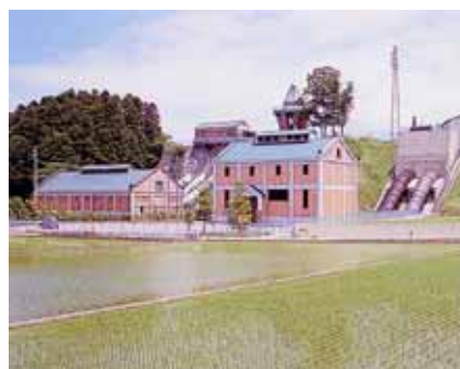
黒東第三発電所の低落差発電
