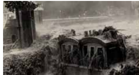
逆巻く濁流(愛本堰堤操作棟)
