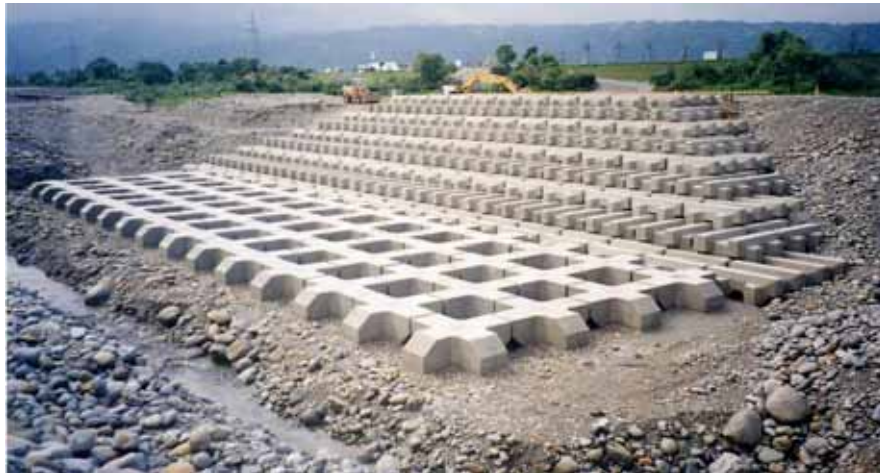
縦工施工状況
