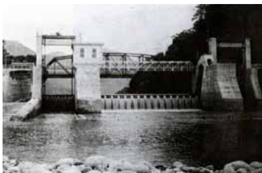
旧・愛本堰堤
