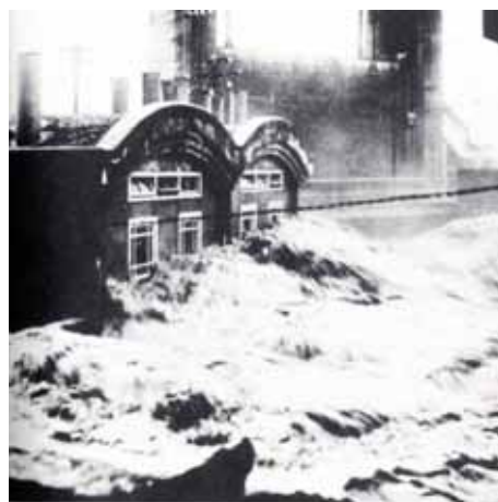
愛本堰堤管理棟より吹き出す流水
