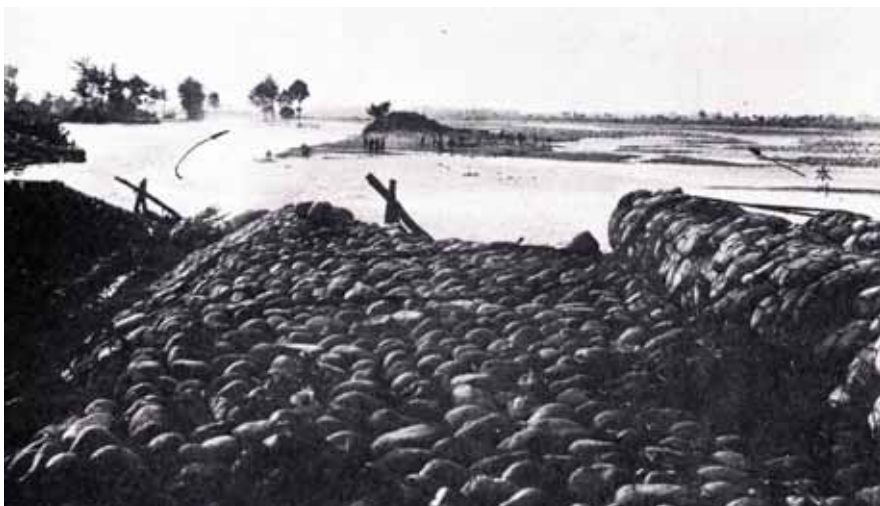
黒部川左岸黒部市五郎八の破堤状況（減水後）
