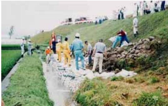
漏水による水防活動状況
