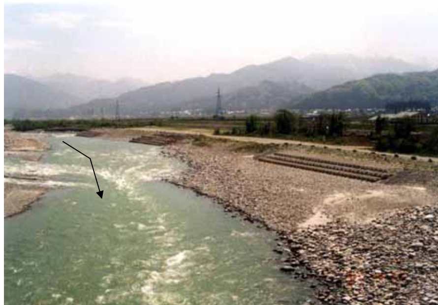
縦工設置状況
