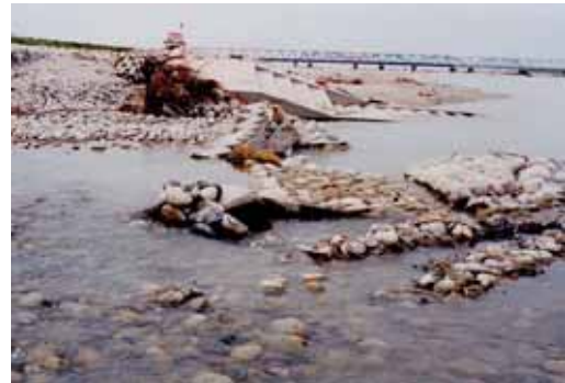
河岸侵食等により被災した護岸
