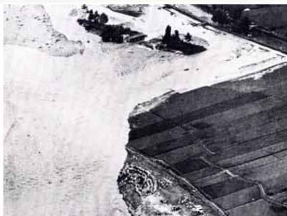
黒部川右岸入善町福島の前堤状況(出水中)
