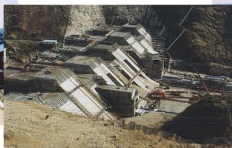
蓮ダム工事写真
