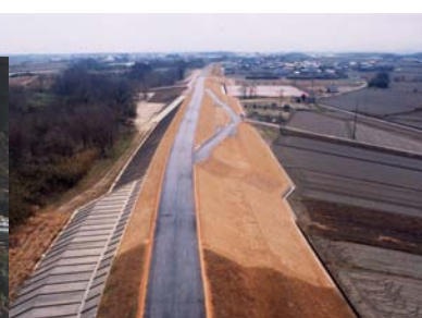
向久保築堤工事 （2-3k 付近）
