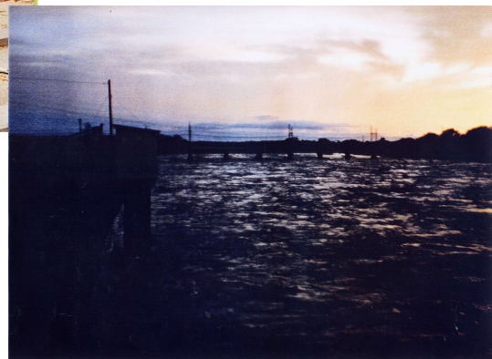
洪水時の状況（7.8k 付近）
