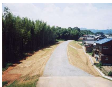
射和地区築堤 (14k 付近)
