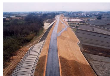
向久保築堤工事 (2～3k 付近)
