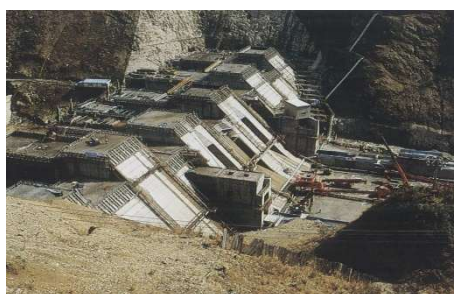
蓮ダム工事写真
