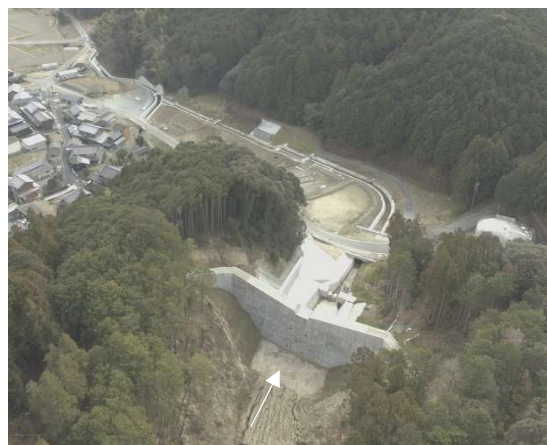
図 2-3 長谷砂防堰堤（平成 30 年（2018 年））
