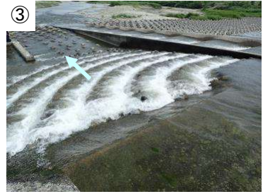
③ 水叩きに滞留する魚類が上れるよう扇形魚道を新設
