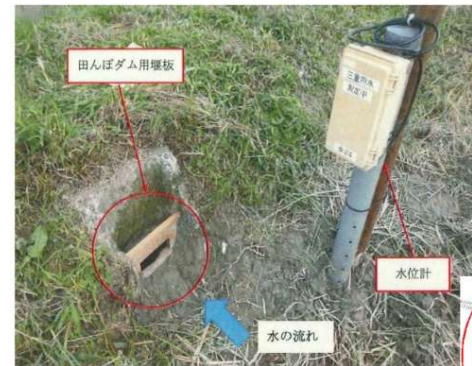
田んぼダム用セキ板及び水位計設置状況
