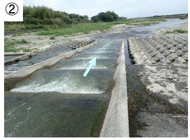
② 滞筋から魚が上りやすい位置に魚道を新設
