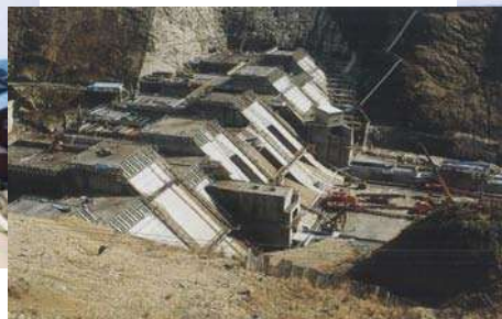
蓮ダム工事写真
