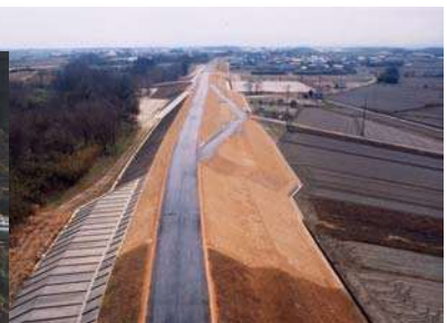
向久保築堤工事 (2・3k 付近)
