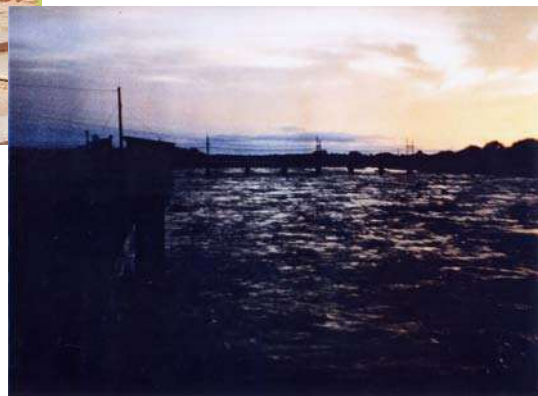
洪水時の状況（7.8k 付近）
