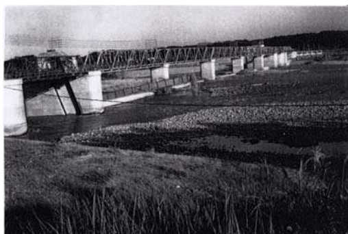
橿田川頭首工(可動化前の橿田可動堰)
