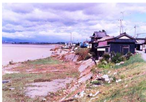
松名瀬地区（1.8k付近） 平成2年9月洪水
