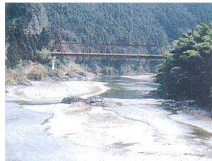
舟戸の渡し場跡（桜橋手前の岩場） 熊野街道筋にあたる渡し場跡で、大正時代まで利用されていた。
