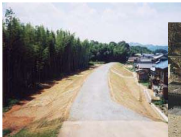
射和地区築堤 (14k 付近)
